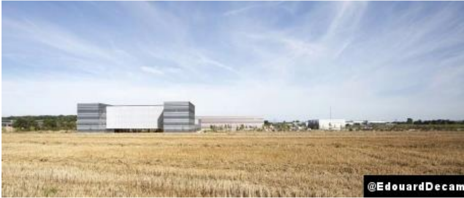
Pôle de Recherche Ecotox sur le campus de Revoltain à Valence
